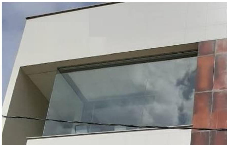
Figura 2 (janelas para fachada e sala de reunião) vidro laminado 12mm fumê, fixo com estrutura de alumínio
